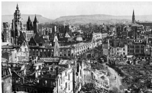
Durch Luftangriffe zerstörtes Heilbronn, 1945
