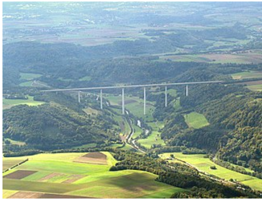
Die Kochertalbrücke in Hohenlohe ist Deutschlands höchste Talbrücke
